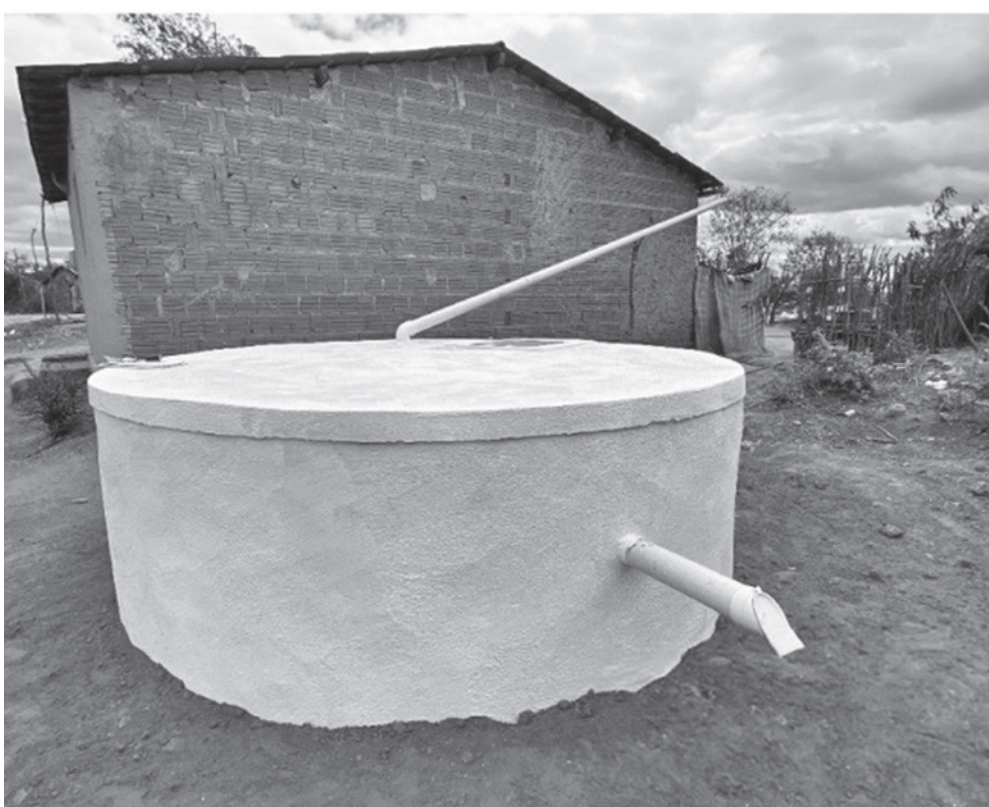
As cisternas de placas beneficiam a população rural com a captação de água da chuva
